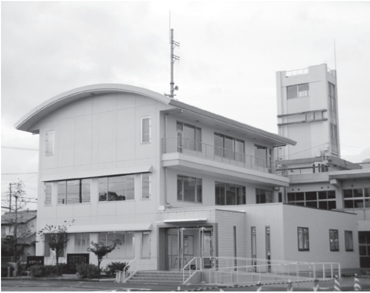
▲改修中の佐織支所
